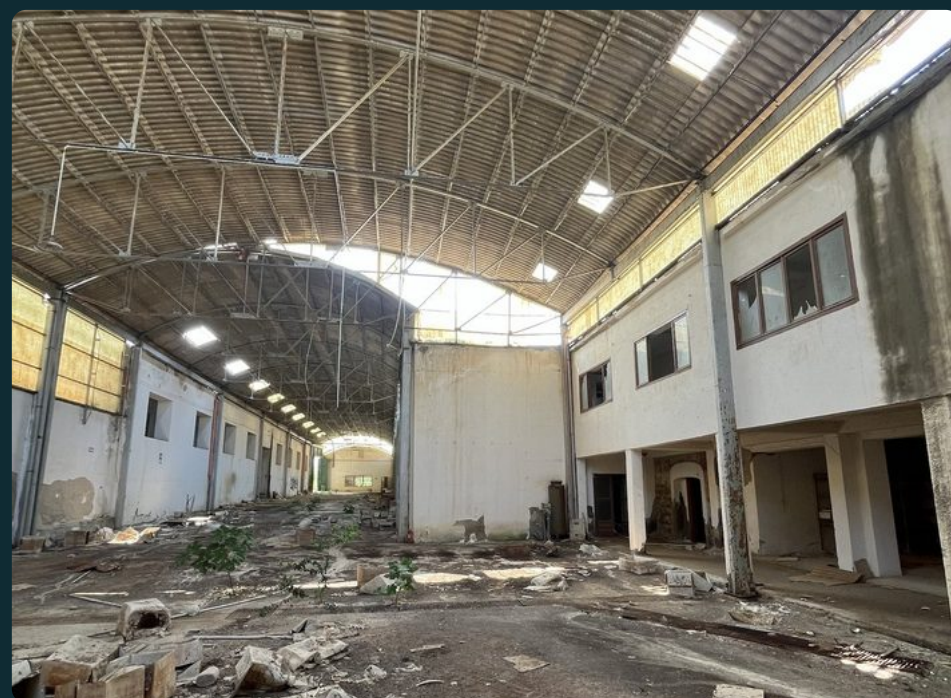
Il capannone centrale: campata unica e lucernari
