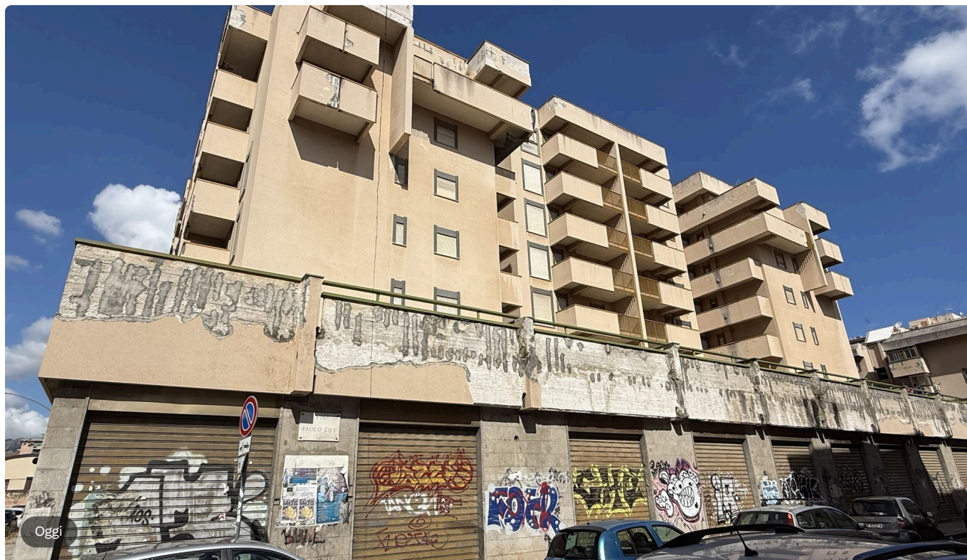
Lo stato attuale dell'angolo su via Paolo Gili.
