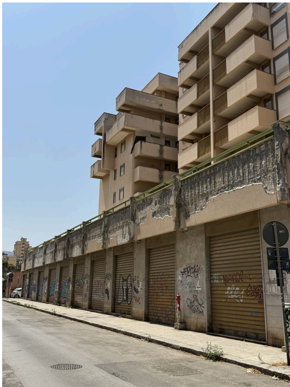
La sequenza di saracinesche lungo il fronte stradale.
