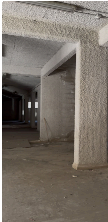
Struttura a pilastri e travi.
